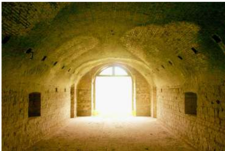
interno di un locale di Forte Portuense
